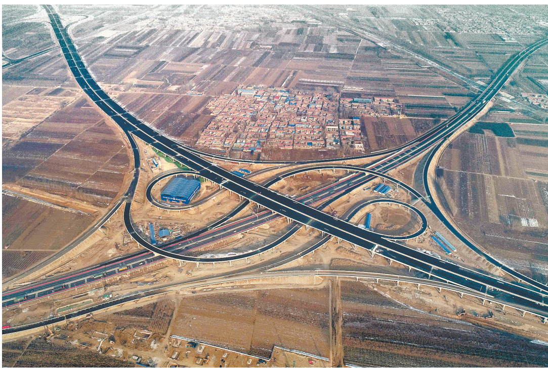
日前,北京大兴国际机场北线高速公路廊坊段主体工程完工。该路段全长9.97公里,设计时速120公里,双向8车道,通车后将缩短北京大兴国际机场到河北廊坊市区的车程时间,方便居民出行。图为该路段王场互通枢纽。 新华社记者 牟宇摄
