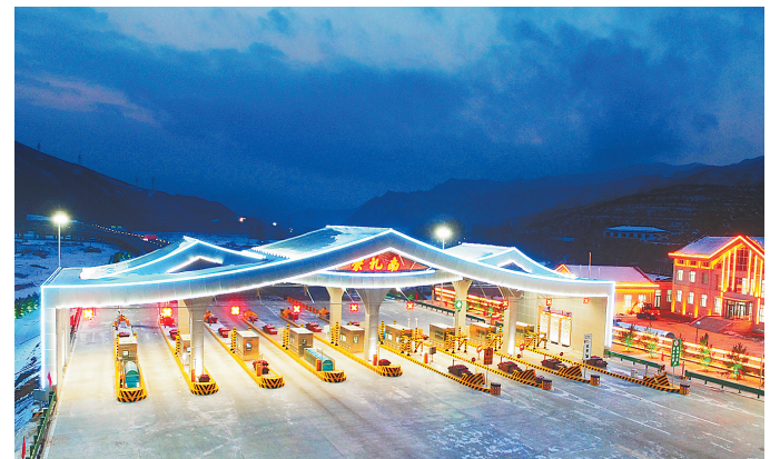
近日,张承高速公路崇礼南互通改建项目工程顺利交工验收,正式通车运行,为服务2022年冬奥会提供了有力保障,对推动崇礼区经济社会发展也具有重要意义。
