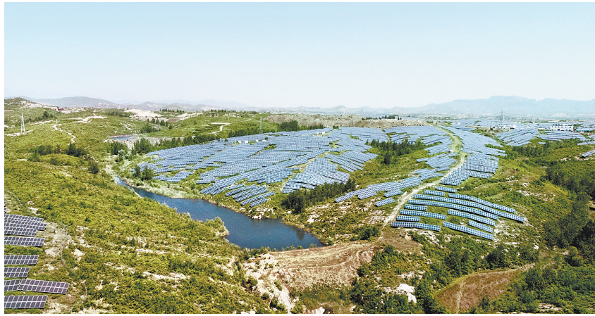
图为建行邢台分行提供贷款支持的临城土寨20兆瓦光伏扶贫项目。 李净怡摄
