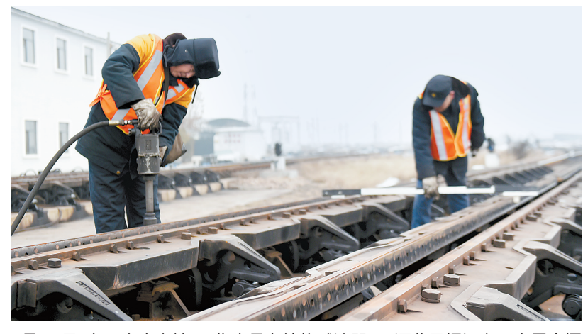
1月15日,在石家庄南站,工作人员在检修减速器。河北日报记者 史晟全摄
