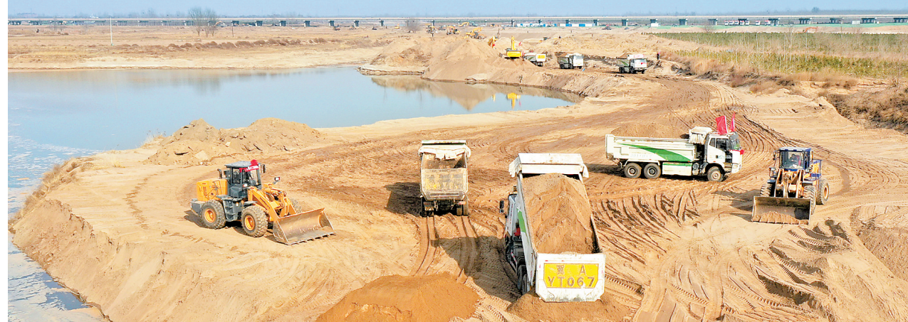
2月18日,石家庄市藁城区境内的滹沱河生态修复二期工程工地正在施工(无人机照片)。新华社记者 杨世尧摄
