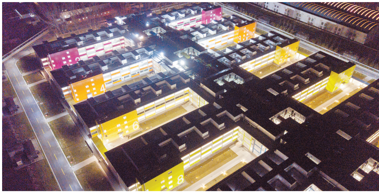
3月16日晚拍摄的北京小汤山医院局部(无人机照片)。为做好境外输入人员疫情防控工作,3月16日起,北京市启用小汤山医院。医院设床位1000余张,将主要用于境外来(返)京人员中需筛查人员、疑似病例及轻型、普通型确诊患者的筛查和治疗。
