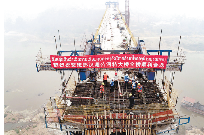
中老铁路全线墩身最高、跨度最大桥梁——班那汉湄公河特大桥4月1日实现大桥主桥合龙。新华社发
