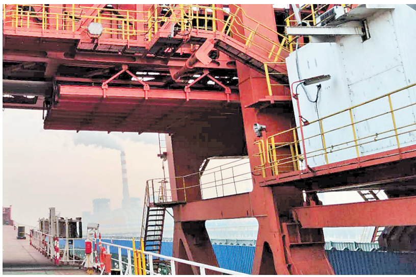
图为近日拍摄的安装在曹妃甸港现场智能感知系统的曹妃甸港一角。 河北日报通讯员 崔琳琳
