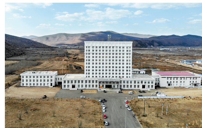
这是4月10日在黑龙江省绥芬河市拍摄的由办公楼改建的方舱医院(无人机照片)。新华社记者 齐泓鑫摄
