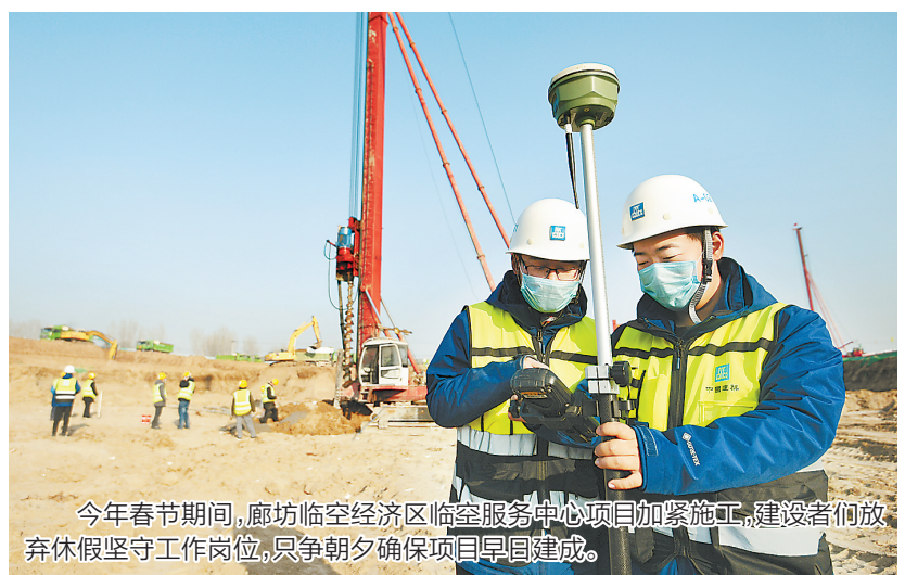
今年春节期间，廊坊临空经济区临空服务中心项目加紧施工，建设者们放弃休假坚守岗位，只争朝夕确保项目早日建成。
