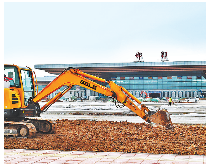
近日,工人们在平整邯郸机场新航站楼外部广场的地面。目前,邯郸机场新建1.8万平方米航站楼工程主体已经完工,正在进行内部专用设备的安装调试。预计今年第二季度邯郸机场改扩建工程将全部完工,三季度将投入使用。 河北日报记者 耿辉摄
