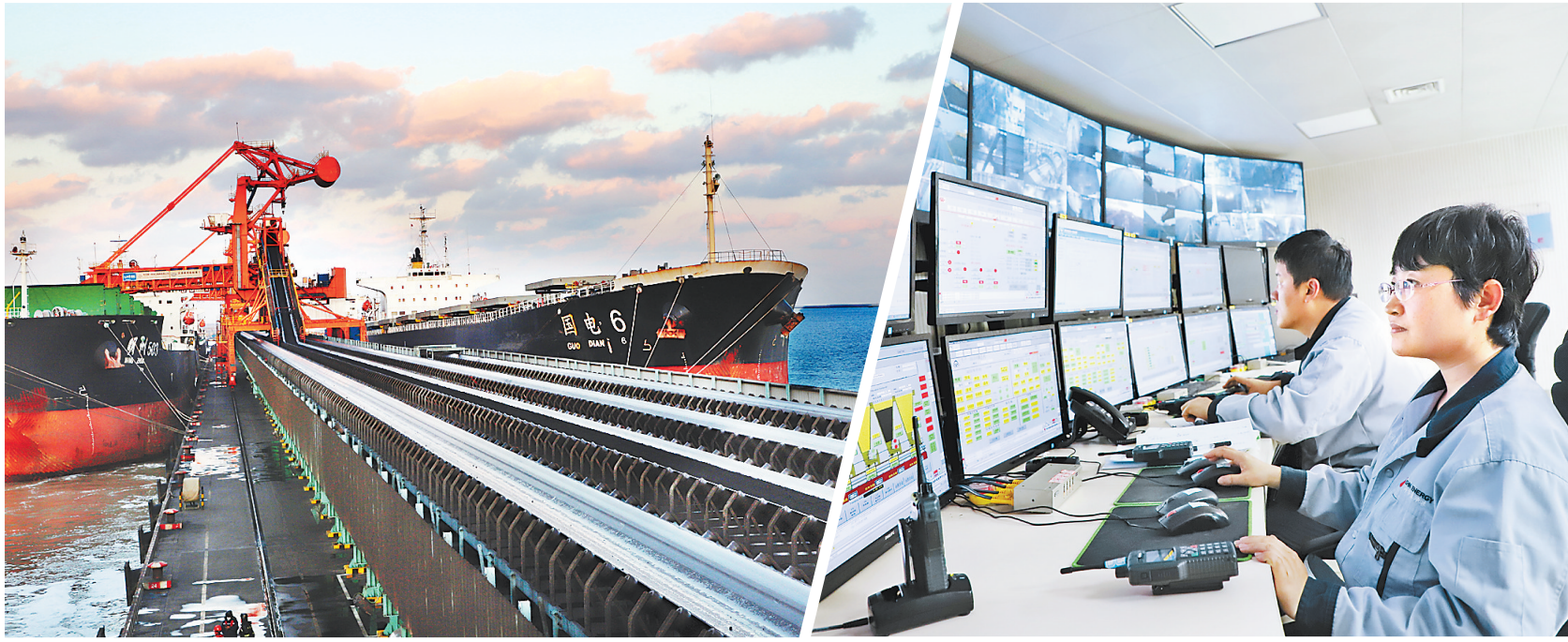
▲煤炭装船过程智能化自动化,现场看不到操作人员,只有机器在有运转。 河北日报通讯员 魏志广摄
