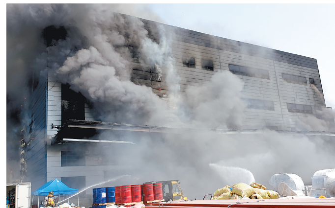
4月29日,韩国京畿道利川市某物流仓库施工现场发生火灾,导致至少36人死亡、10人受伤。新华社发
