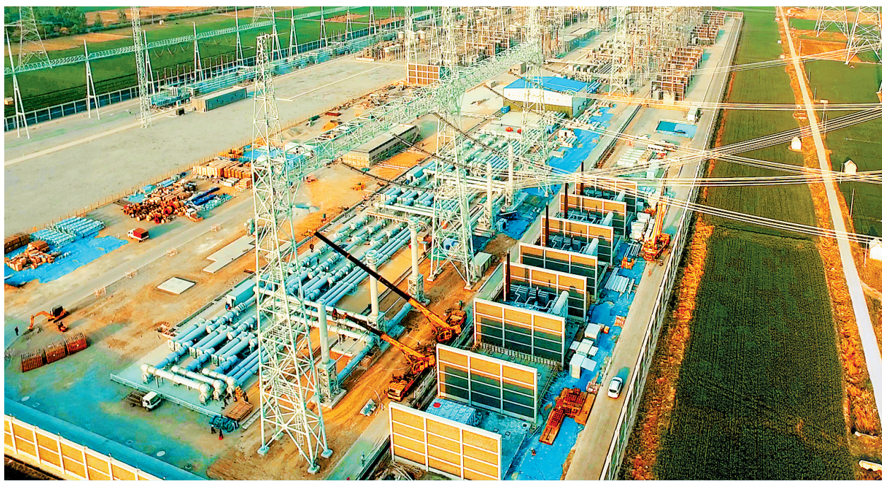
图为4月29日拍摄的国网河北电力张北至雄安1000千伏特高压交流输电工程变电站三期扩建工程作业现场。该工程是国家电网公司规划建设特高压交流电网的重要组成部分,是清洁能源外送工程。目前,该工程河北段进场工人达1200余名,完成铁塔运输6200余吨,导线进场448.7千米,组塔施工完成14基。河北日报记者 田瑞夫摄
