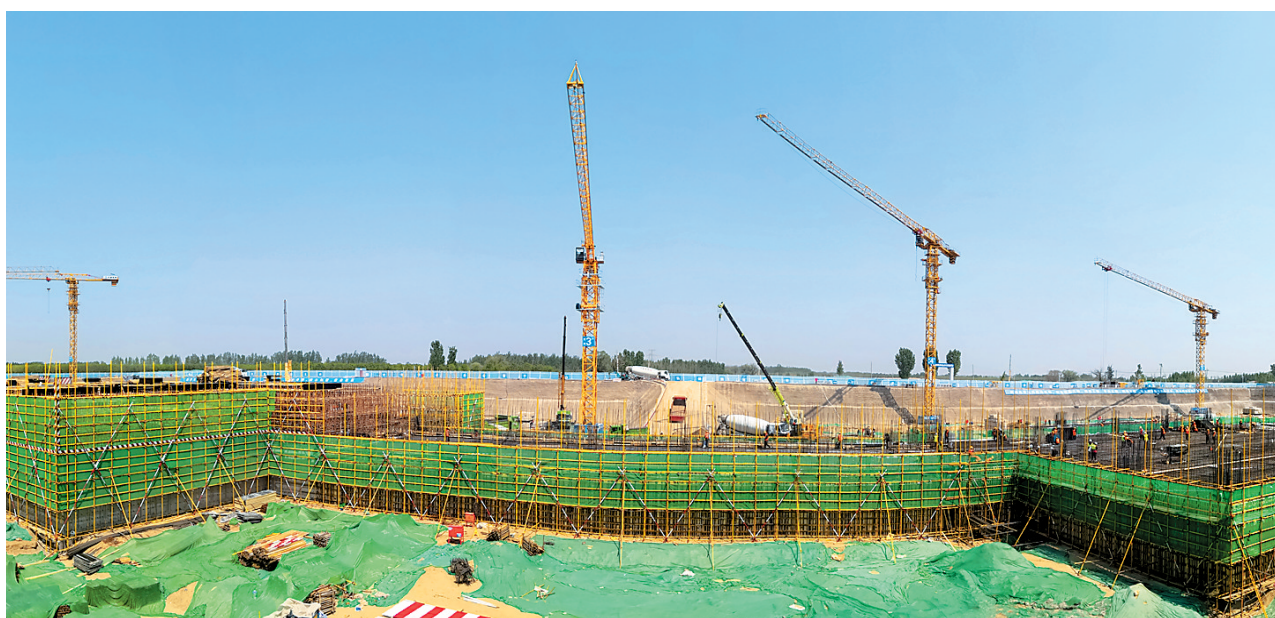
图为正在建设中的廊坊临空服务中心。
