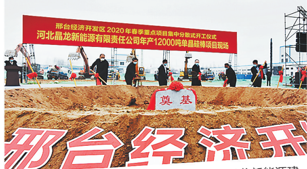
2月24日,晶澳科技全资子公司邢台晶龙新能源建设的年产1.2万吨单晶硅棒项目正式开工。
