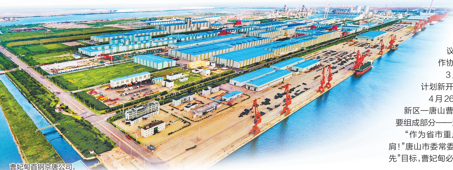
曹妃甸首钢京唐公司。
