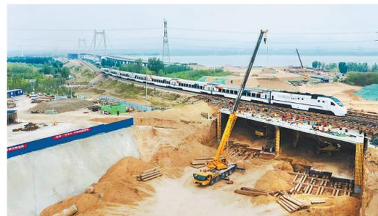
5月15日，省道S228怀来狼山至镇边城公路中的狼山至东花园改建控制性工程——下穿京包铁路框架桥顶进到位。这是框架桥顶进时北京市郊铁路S2线长城号旅游列车驶过。
