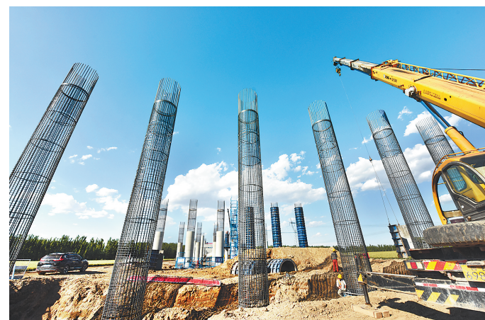
京德高速公路文安段全长32.75公里,投资额为46亿元,涉及苏桥镇、大围河乡、赵各庄镇、大留镇、大柳河镇5个乡镇44个村街,设有3个出口、1个服务区、1个停车区。这是5月27日,工人在京德高速文安6标段桩基现场施工。
