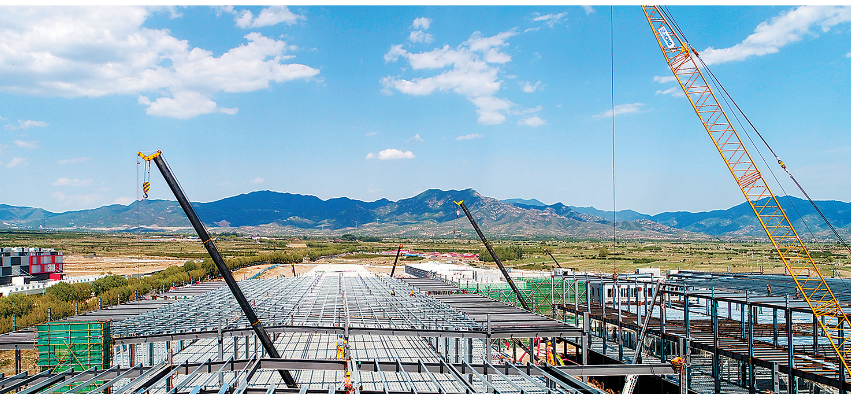
图为6月16日拍摄的建设中的腾讯怀柔北云数据中心项目。该项目是河北省重点项目,总投资300亿元,主体工程预计今年年底完工。
