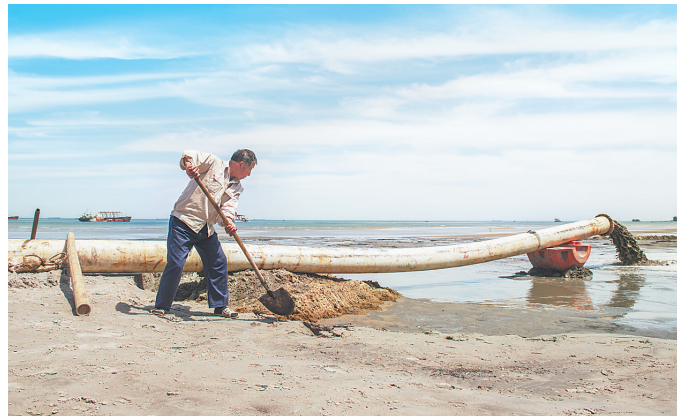
近日,在北戴河区浅水湾浴场,工作人员在进行补沙作业。日前,北戴河区启动浴场入海排洪沟整治及护岸修复工程,对海岸沙滩进行综合治理,进一步提高北戴河旅游景区海滩环境质量。 河北日报记者 赵杰摄
