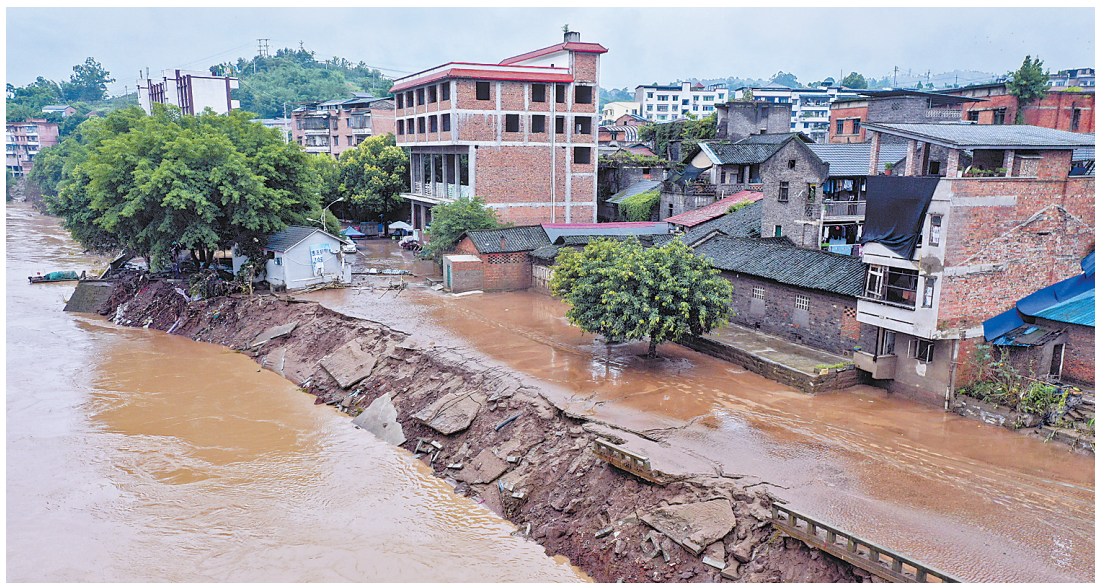
这是7月2日拍摄的重庆江津区贾嗣镇被洪水侵袭后的河岸道路和建筑(无人机照片)。新华社记者刘潺摄
