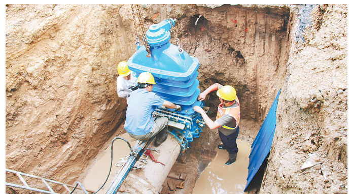
日前,保定供水总公司工作人员对市区一处大口径管道阀门进行加装,其间未对周边市民用水造成影响。该公司持续优化城市供水服务,采用供水抢修新工艺新技术,保障夏季用水高峰期居民用水。
