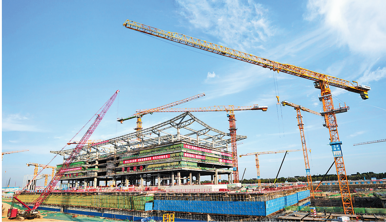
7月24日拍摄的雄安商务服务中心会展中心施工现场。
