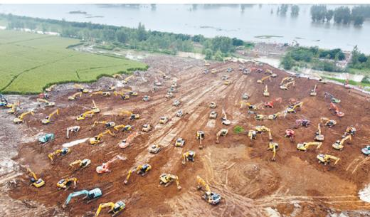
7月28日,在姜唐湖蓄洪区戴家湖一处涵闸险情处置现场,人们操作机械设备在抢筑临时圩堤。26日,位于安徽省颍上县的姜唐湖蓄洪区戴家湖一处涵闸闸门破损,在大堤背后形成直径约10米的漩涡。险情发生后,当地调配大量机械设备现场作业,在大堤背水侧修筑一道长600米的临时圩堤,控制险情。新华社发
