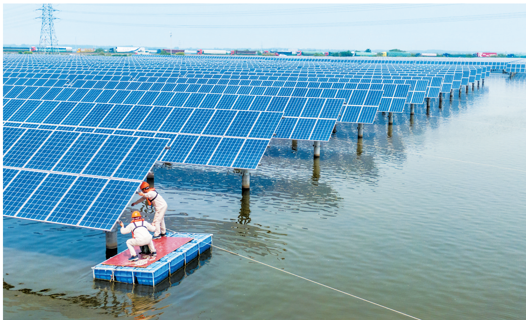
7月30日,唐山市丰南区黑沿子镇,通威“渔光一体”现代渔业产业园工作人员正在检修光伏发电设施。 河北日报记者 赵杰摄
