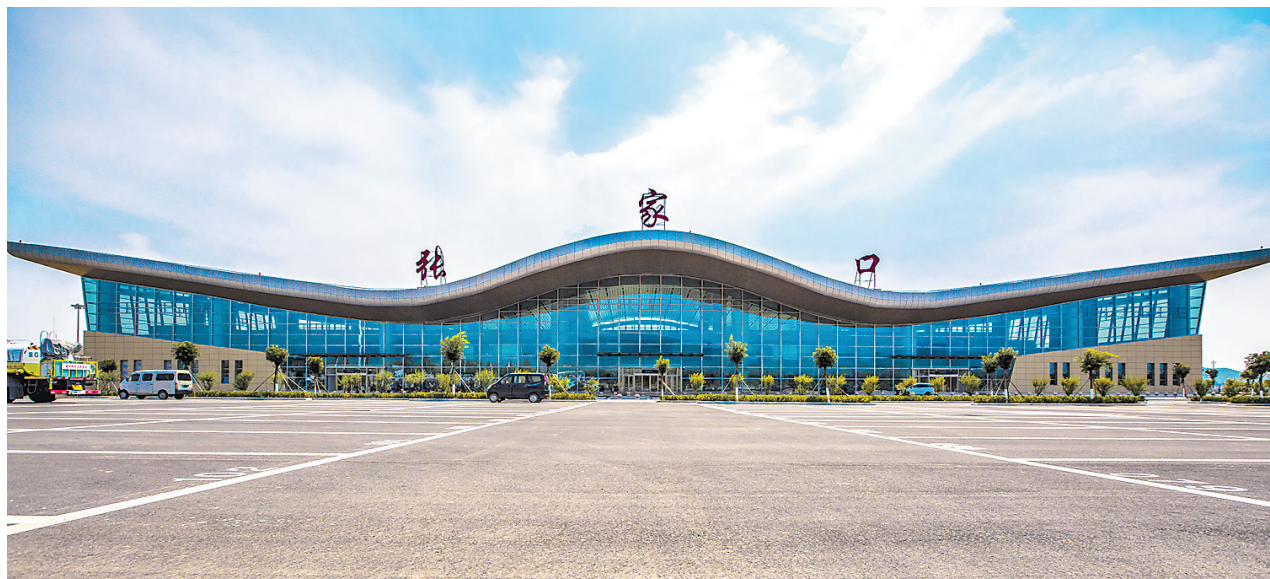
8月3日,张家口机场新建的2号航站楼正式启用。2号航站楼设有6个自助值机设备,旅客可实现无纸化乘机。图为新启用的张家口机场2号航站楼。
