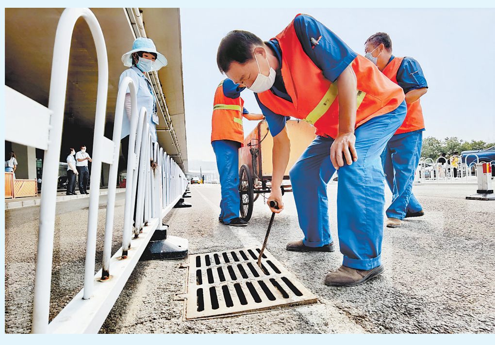
近日，石家庄机场候机楼管理部的工作人员在检查排水管道。河北机场集团积极做好防汛工作，先后完成了排水设施检查、防汛物资储备、抢险队伍建立等工作，全力确保汛期机场安全平稳运行。 河北日报记者 田明摄
