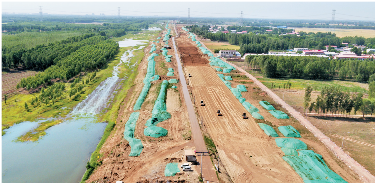
白沟引河右堤防洪治理工程(二标段)土方及景观造型作业现场。
