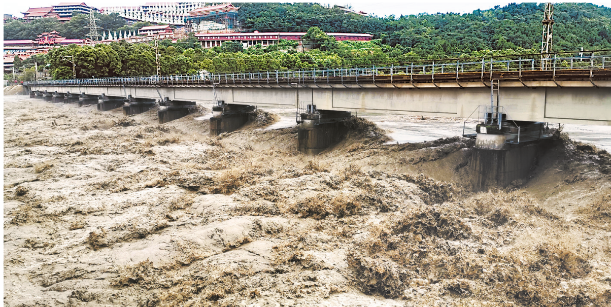
8月17日,洪水冲击位于四川省绵阳市境内的宝成铁路涪江大桥。
