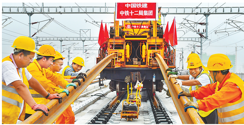
8月17日上午,在京雄城际铁路雄安新区,随着最后一组500米长钢轨平稳铺设完毕,京雄城际铁路实现全线铺轨完成。
