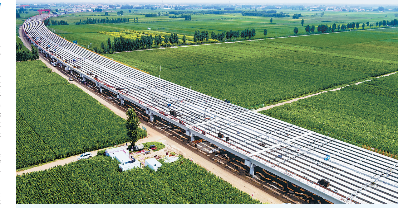
日前拍摄的文安县大留镇镇京德高速ZT10标段建设现场。近日,京德高速河北ZT10标段T梁预制在全线率先突破1000片,标志着京德高速在桥梁建设中取得阶段性突破。该条高速公路建成通车后将有力促进高速公路沿线的经济发展,对提升区域路网服务水平,落实京津冀协同发展具有重要意义。新华社记者 李晓果摄
