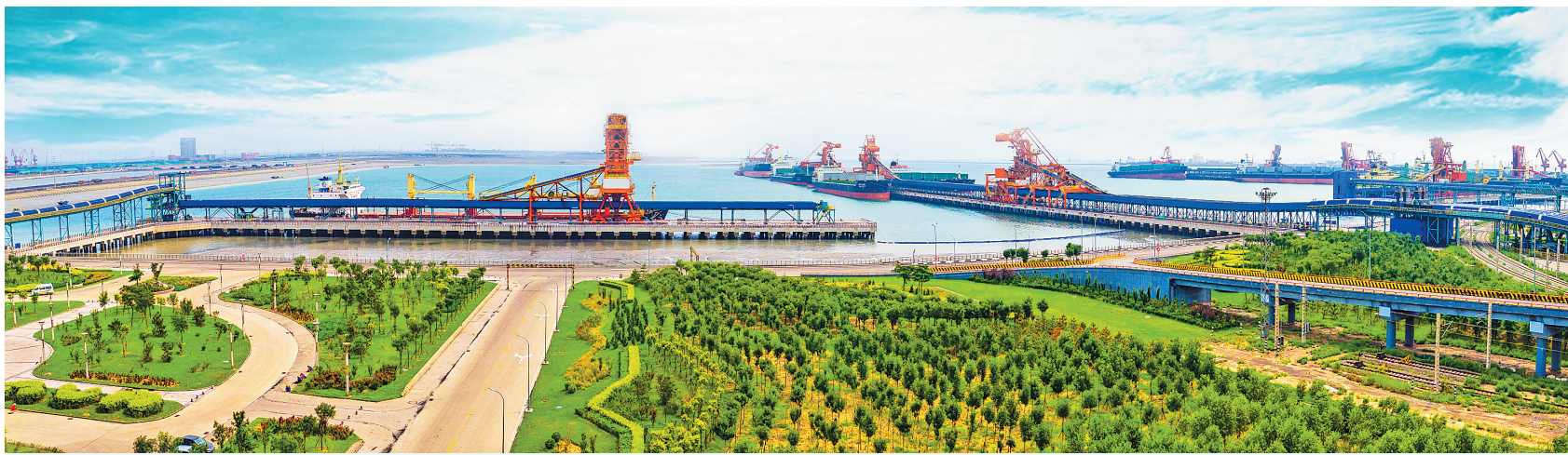
黄骅港煤炭港区装船码头全景。
