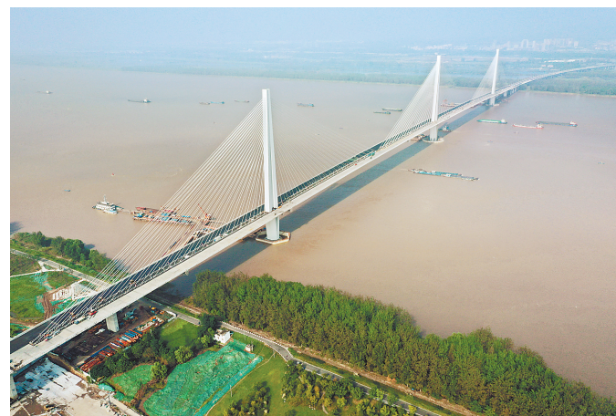
近日,南京长江第五大桥进入跨江主桥沥青混凝土桥面铺装阶段。南京长江第五大桥跨江主桥全长1796米,计划于9月下旬完成跨江主桥沥青混凝土铺装作业,进入桥面荷载试验阶段。 新华社发
