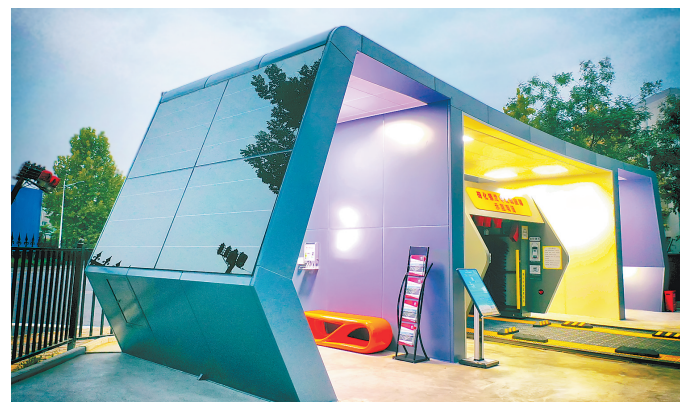
日前,全国首台碲化镉薄膜发电玻璃清洗机在邯郸市建成投入使用。该清洗机共使用22块碲化镉薄膜发电玻璃,通过光电转化,将太阳能转化为电能,推动洗车设备启动运行,日发电量约20千瓦时。河北日报通讯员 蔡文杰摄
