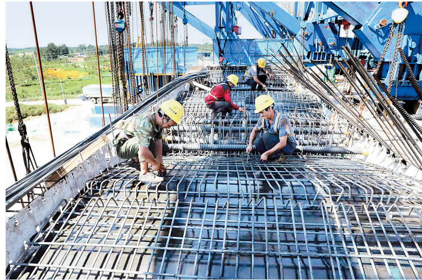
10月1日,雄安新区京雄高速SG6标段项目建设现场。项目建设方供图
