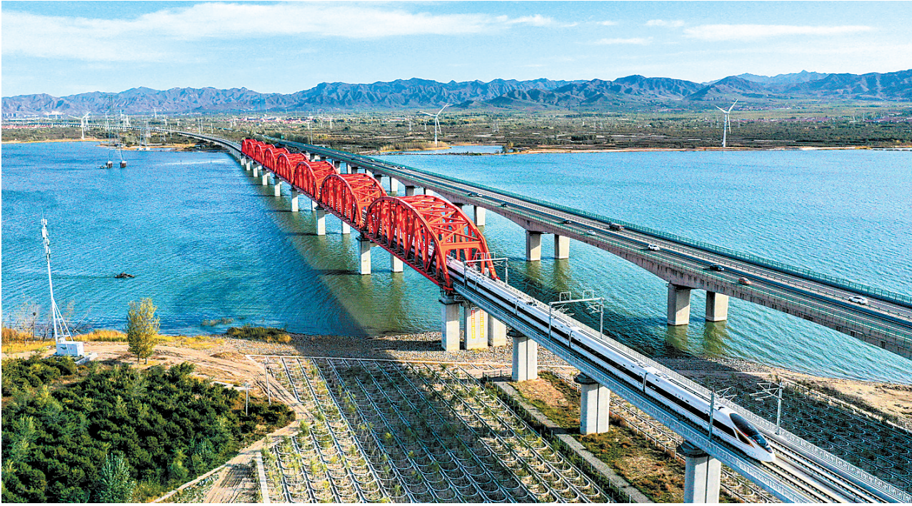
10月13日,一列复兴号动车组列车从京张高铁官厅水库特大桥上驶过。
