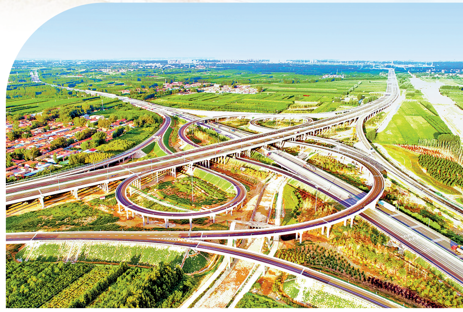
大兴国际机场北线高速公路王场互通。
