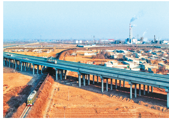
邢台市环城公路跨旭阳铁路桥(钢混组合桥梁)。
