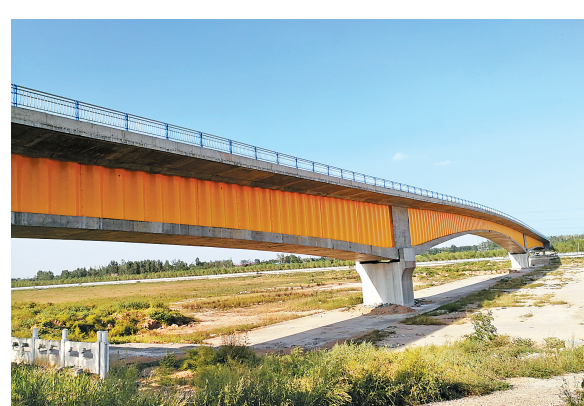
邢台市紫金特大桥(波形钢腹板钢混组合桥梁)。
