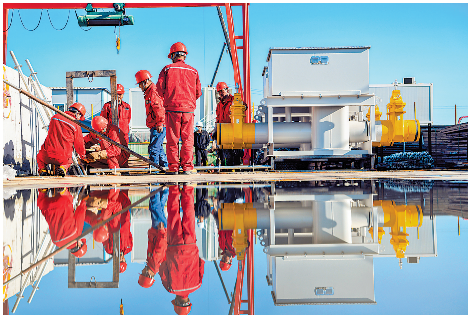
10月24日,高铁站片区供热(冷)工程1号能源站项目施工现场,工人在安装燃气压力转换站。 河北日报通讯员 任双双摄
