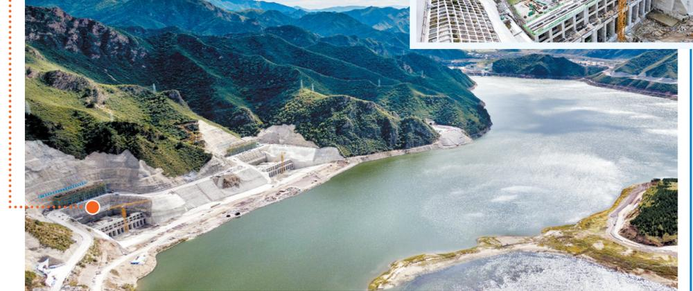
“四周山高百米,只需修筑一道大坝,便能形成流域面积4.4平方公里、库容4814万立方米的水库。”马雨峰说,经过反复论证设计,2013年5月,丰蓄电站工程正式开工。
