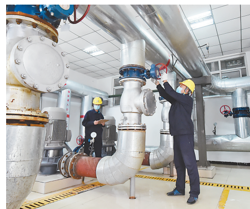
10月29日,石家庄华电供热集团有限公司广平换热站的工作人员在调试新升级改造的供热设备。河北日报记者 史晟全摄
