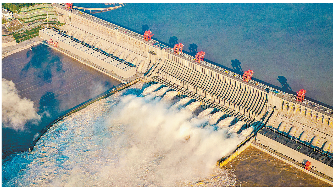
11月1日，水利部、国家发展改革委公布，三峡工程日前完成整体竣工验收全部程序。
