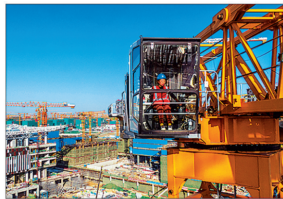
上图:唐燕全神贯注地操作塔吊。
