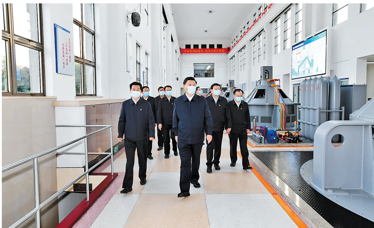
11月12日至13日，中共中央总书记、国家主席、中央军委主席习近平在江苏考察。这是13日下午，习近平在扬州市江都水利枢纽第四抽水站，察看抽水泵运行情况。新华社记者 谢环驰摄
