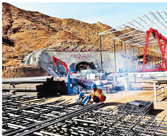
近日，位于尚义县小蒜沟镇的抽水蓄能电站项目在紧张施工中。该电站为国家“水电发展‘十三五’规划”重点开工项目，总装机容量1400MW，总投资95.65亿元，电站建成后有效保障北京供电安全。 河北日报通讯员 武殿森摄
