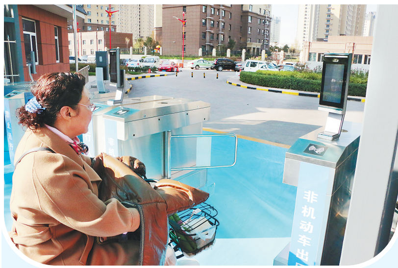
▲邯鄯市公租房小区民悦苑配备了人脸识别门禁系统,让居民享受智慧社区带来的安全便利。邯鄯市住房保障和房产管理局供图
