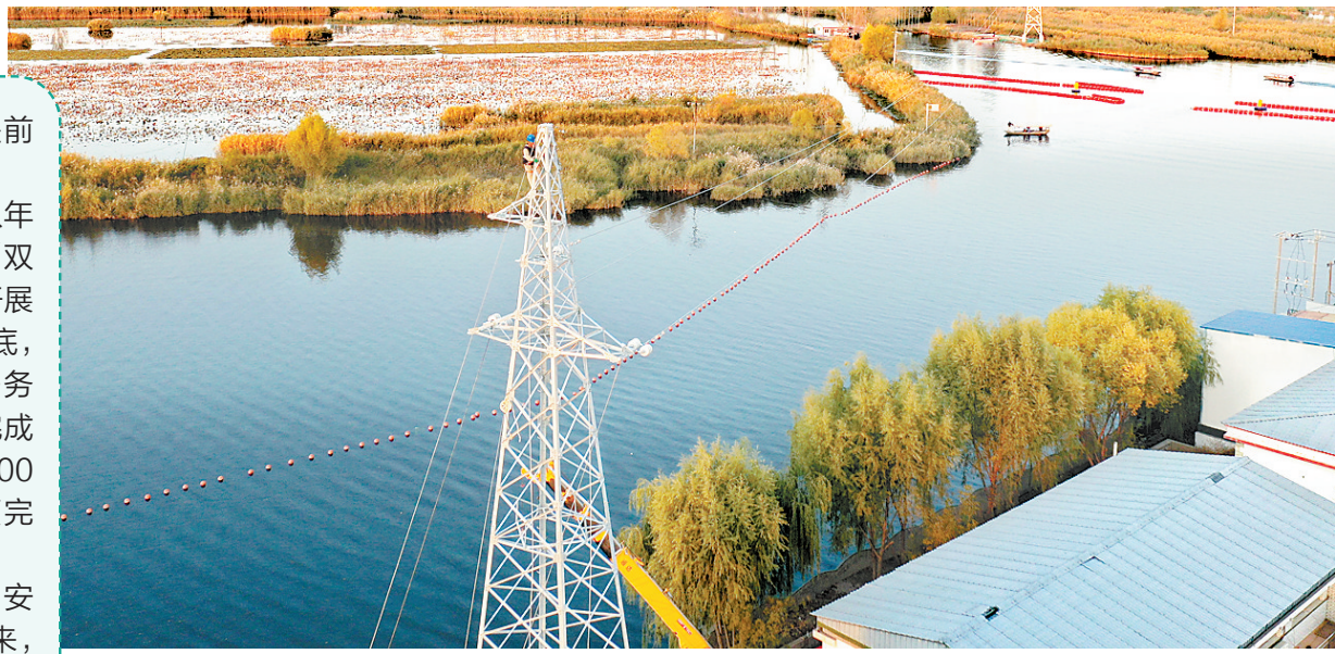
10月31日,安新县10千伏赵庄子线成功合闸送电,雄安新区2020年“电代煤”配套电网改造任务全面竣工。图为安新县10千伏赵庄子“电代煤”线路建设现场。 河北日报通讯员 马晶摄
