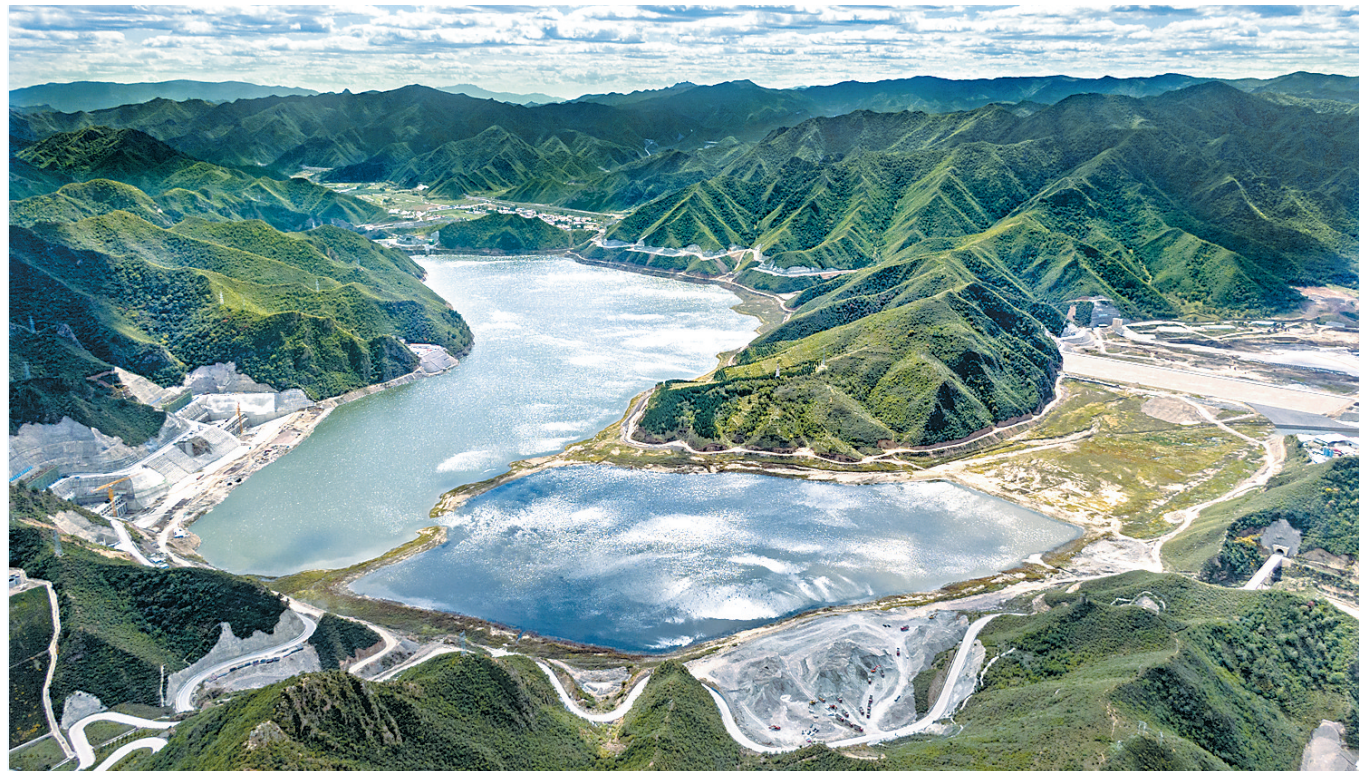
图为近日拍摄的河北丰宁抽水蓄能电站下水库。该抽水蓄能电站是全球装机容量最大的抽水蓄能电站,工程项目装机规模360万千瓦,总投资192.37亿元,2013年5月正式破土开工建设,首台机组预计将于2022年6月投入发电。日前,抽水蓄能电站土建工程已经基本完成,全面进入设备安装和电网架设计冲刺阶段。 河北日报记者 田明摄
