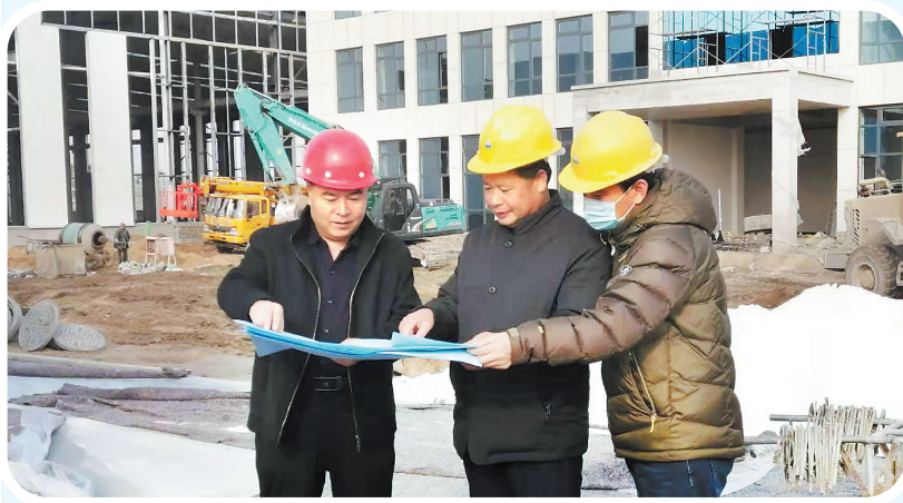
近日，河间经济开发区管委工作人员(中)在河北康百特电力科技有限公司施工现场帮助企业解决问题，为保障项目冬季施工做好全方位服务。河间市委组织部供图
