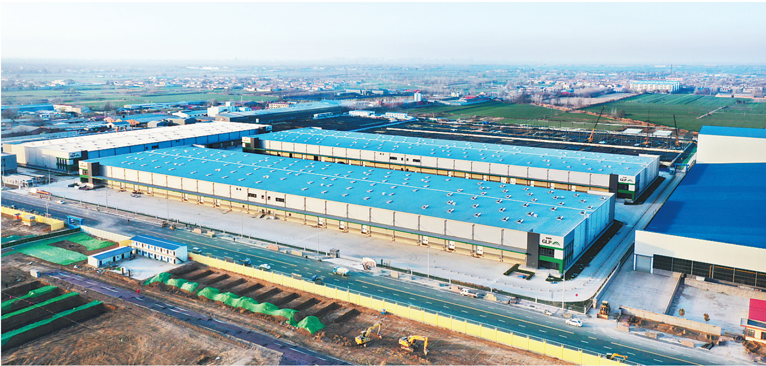
今年以来,晋州市工业项目指挥部积极围绕区域产业发展定位开展精准招商,引进了普洛斯物流园等一批重点项目。这是晋州经济开发区正在建设中的普洛斯物流园项目。 河北日报通讯员 贾再兴摄
